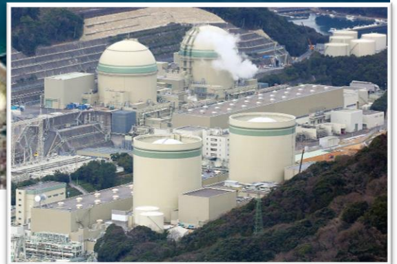
高浜原子力発電所1・2号機
