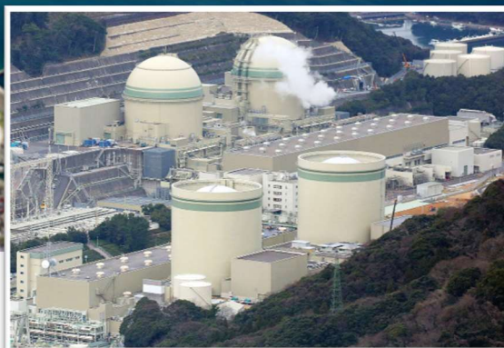
高浜原子力発電所1・2号機
